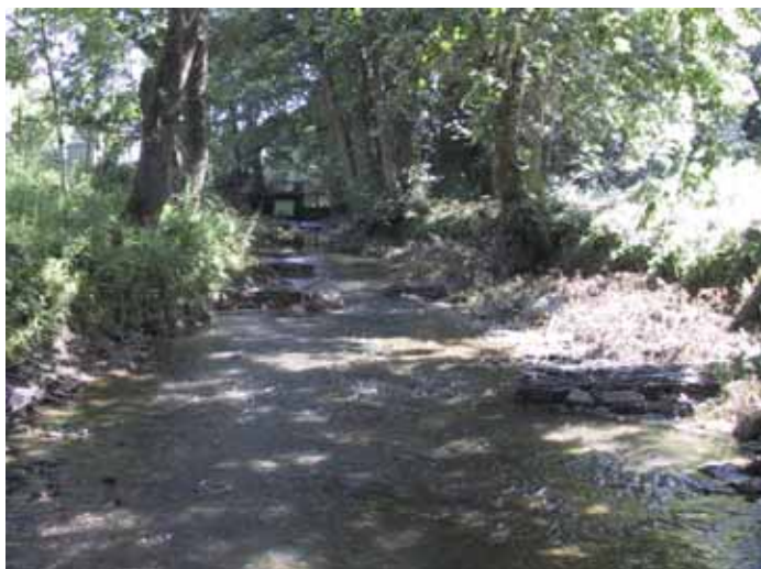
Restauration de la Vence à Poix Terron (08).
